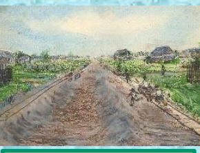
秩父通の舗装工事
